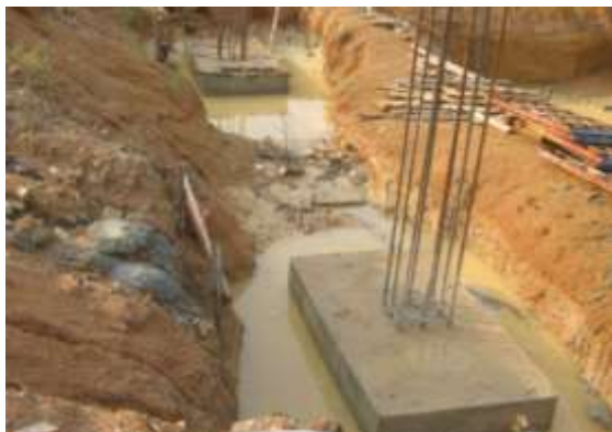
รูปที่ 3.21 แสดงการบ่มคอนกรีตฐานรากโดย น้ำขัง
