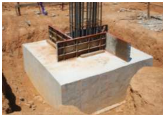
รูปที่ 3.22 แสดงฐานรากที่เสร็จสมบูรณ์แล้ว เตรียมถมดินกลบ
