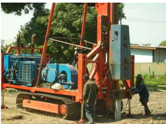
รูปที่ 3.36 แสดงการตอกเสาเข็มโดยปั้นจั่นโมบาย
