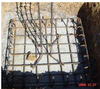
รูปที่ 3.1 แสดงการวางเหล็กฐานราก
