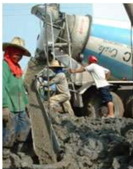
รูปที่ 3.44 แสดงการเทคอนกรีตลงเสาเข็มเจาะ
