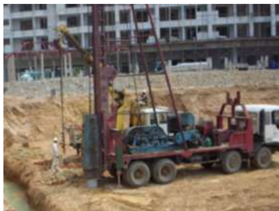
รูปที่ 3.31 แสดงการตอกเสาเข็มโดยใช้รถปั้นจั่น
