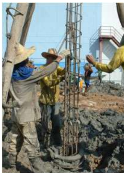
รูปที่ 3.43 แสดงการใส่เหล็กเสริมลงในปลอกเหล็กชั่วคราวที่ทำหน้าที่เป็นแบบหล่อ
