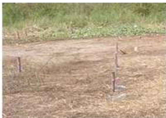
รูปที่ 3.32 แสดงการวางหมุดเสาเข็ม
