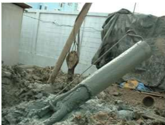
รูปที่ 3.42 แสดงการตักดินออกจากรูเจาะที่จะทำเข็มเจาะ
