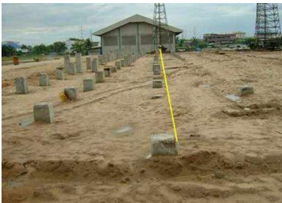
รูปที่ 3.38 แสดงการเช็กแนวของเสาเข็ม จะเห็นว่าเสาเข็มหนีแนว ซึ่งจะต้องรายงานส่งต่อผู้รับผิดชอบ
