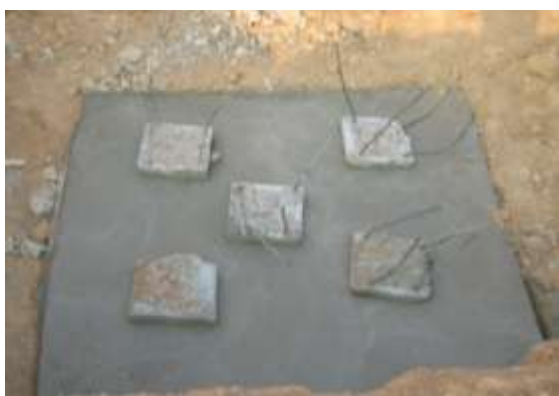
รูปที่ 3.16 แสดงการเทคอนกรีตหยาบรองกันหลุมฐานราก จะต้องเทคอนกรีตให้ต่ำกว่าหัวเสาเข็มเล็กน้อย
