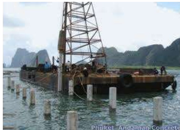
รูปที่ 3.35 แสดงการตอกเสาเข็มโดยปั้นจั่นในน้ำ
