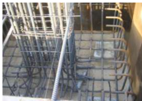
รูปที่ 3.17 แสดงการประกอบเหล็กเสริมเสากับเหล็กเสริมฐานราก ในขั้นตอนนี้จะต้องตรวจสอบให้ได้แนวศูนย์กลาง
