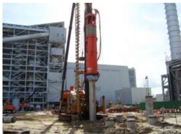
รูปที่ 3.37 แสดงการตอกเสาเข็มแรงเหวี่ยง ด้วยเครื่อง Hammer Diesel
