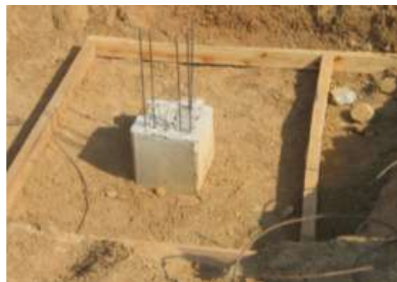
รูปที่ 3.15 แสดงการตัดหัวเสาเข็มและการทำแบบหล่อเพื่อเทคอนกรีตหยาบกันหลุมฐานราก
