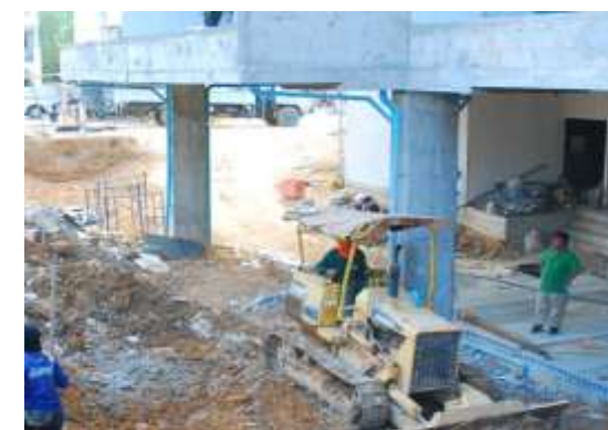
รูปที่ 5.24 ท่อระบายน้ำฝนจากระเบียงไหลลงสู่บ่อพักโคนเสา
