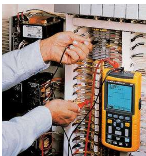
รูปที่ 5.96 การตรวจสอบคู่สายของโทรศัพท์ภายในอาคาร เช่น โรงแรม คอนโดมิเนียม
