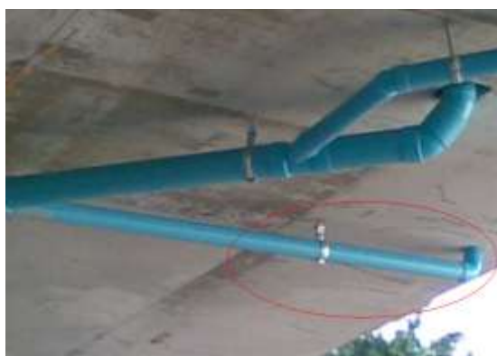
รูปที่ 5.22 การเชื่อมต่อท่อระบายน้ำฝนจากระเบียงไปยังท่อเมนก่อนลงท่อระบายน้ำในอาคาร
