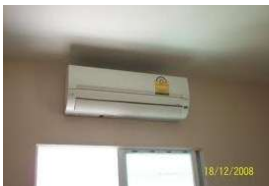
รูปที่ 5.99 ต้องติดตั้งแอร์ให้มีความมั่นคงและแข็งแรง
