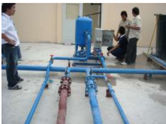
รูปที่ 5.11 ทำการทดสอบปั๊มและทำความสะอาดท่อ พร้อมใส่คลอรีนเพื่อฆ่าเชื้อโรคภายในท่อ 1 ครั้งก่อนปล่อยน้ำ
