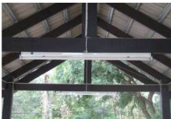
รูปที่ 5.65 การติดตั้งโคมลอยในอาคารที่ไม่มีฝ้า
