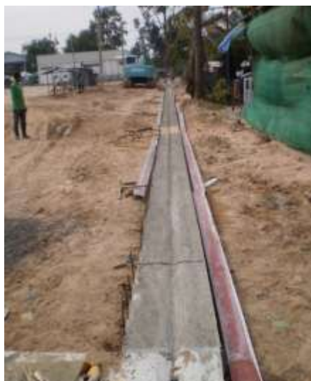
รูปที่ 5.32 รางระบายน้ำรูปตัววีขอบถนนหลังจากเทคอนกรีตเสร็จ
