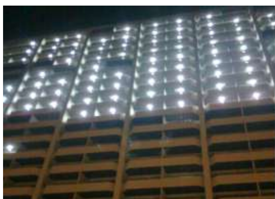
รูปที่ 5.85 เริ่มเปิดไฟฟ้าแสงสว่างในอาคาร
