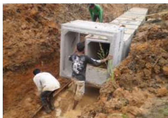
รูปที่ 5.30 การติดตั้งท่อกี่เหลี่ยม (Block Convert)
