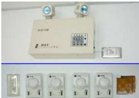
รูปที่ 5.79 การติดตั้งงานระบบที่ผนังก่ออิฐ ฉาบปูนทาสี
