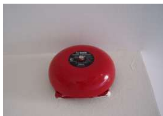
รูปที่ 5.82 อุปกรณ์ส่งสัญญาณเตือนอัคคีภัย (Alarm) ทดสอบความดังของเสียงก่อนการ ใช้งาน
