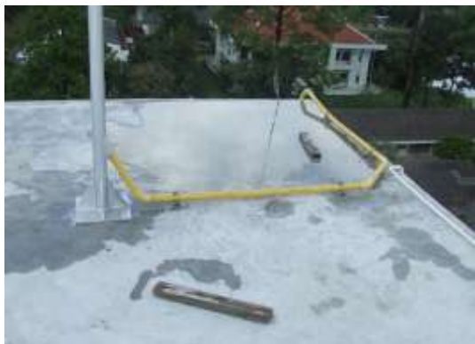
รูปที่ 5.113 การวางแท่ง Ground Loop ต้องวาง อย่างเป็นระเบียบเรียบร้อย ตามที่ระบุไว้ในแบบ
