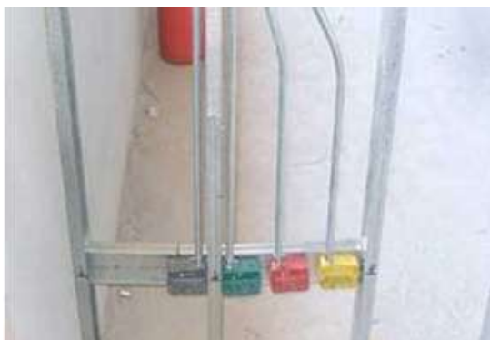
รูปที่ 5.75 การติดตั้งท่อร้อยสายไฟฟ้าแบบฝังในผนังเบา
