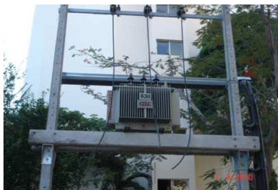
รูปที่ 5.47 หลังจากการติดตั้งหม้อแปลงไฟฟ้าแล้วต้องดูแลระยะห่างของหม้อแปลงกับรั้วบ้านให้มีระยะห่างที่ปลอดภัย
