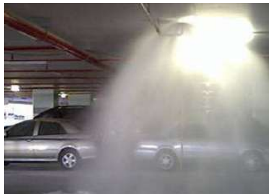
รูปที่ 5.106 หลังจากการติดตั้งต้องมีการทดสอบการใช้งานจริงของสปริงเกอร์ โดยการรดน้ำด้วยเปลวไฟว่าทำงานได้ตามข้อกำหนดหรือไม่
