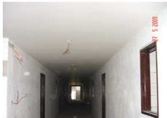
รูปที่ 5.70 ตรวจสอบตำแหน่งการเชื่อมต่อท่อไฟฟ้ากับบล็อกของดวงคอมปลักไฟและสวิตช์ให้ตรงตำแหน่ง
