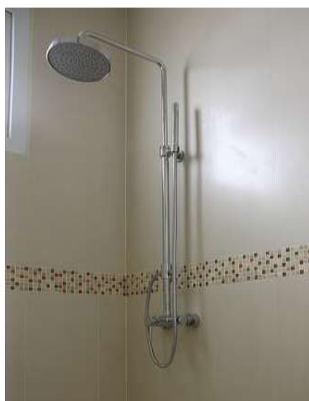
รูปที่ 5.37 การติดตั้งฝักบัวอาบน้ำ
