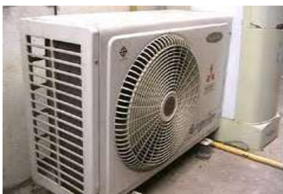
รูปที่ 5.101 คอมเพรสเซอร์แอร์ต้องติดตั้งในบริเวณที่มีอากาศถ่ายเทสะดวก
