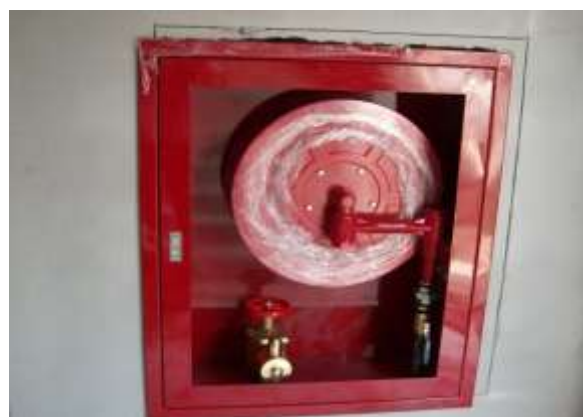
รูปที่ 5.12 ตรวจสอบตำแหน่งการวางหัวดับเพลิงและการใช้งาน
