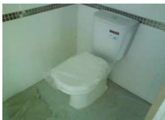
รูปที่ 5.35 การติดตั้งโถชักโครกชนิดนั่งราบ
