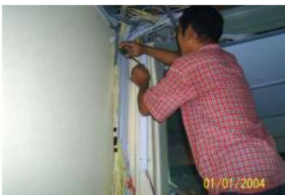
รูปที่ 5.95 การเดินสายสัญญาณต่างๆ ภายในอาคาร
