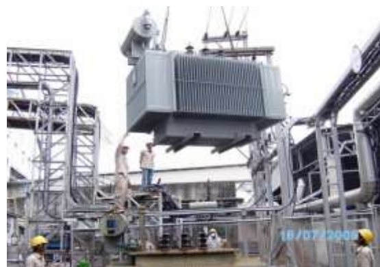
รูปที่ 5.46 การเคลื่อนย้ายหม้อแปลงไฟฟ้าไปยังแท่นติดตั้งต้องกระทำอย่างระมัดระวัง
