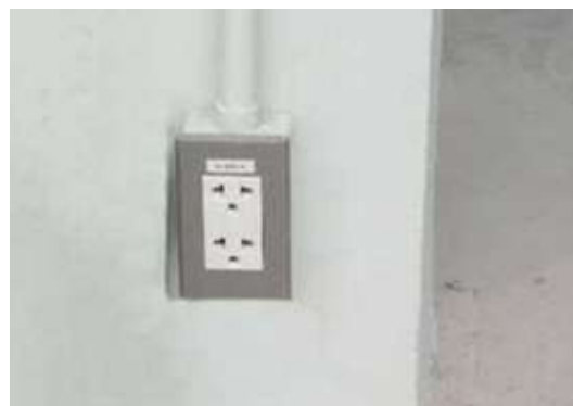
รูปที่ 5.76 เตารับไฟฟ้าแบบเดินลอยผนังก่อนฉาบ
