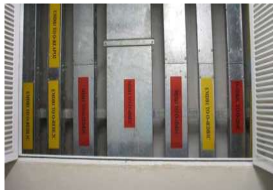
รูปที่ 5.72 การติดตั้งรางเดินสายในช่อง Shaft พร้อมแสดงรหัสสี และสัญลักษณ์
