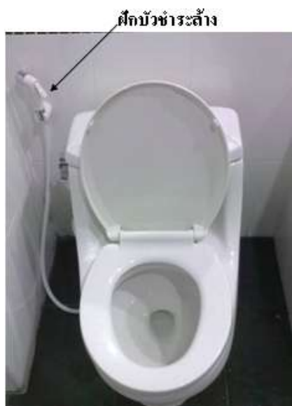
รูปที่ 5.39 การติดตั้งฝักบัวชำระ
