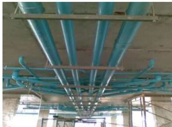
รูปที่ 5.4 การเดินท่อน้ำใต้เพดาน โดยใช้ อุปกรณ์แขวนยึดติดท้องพื้น
