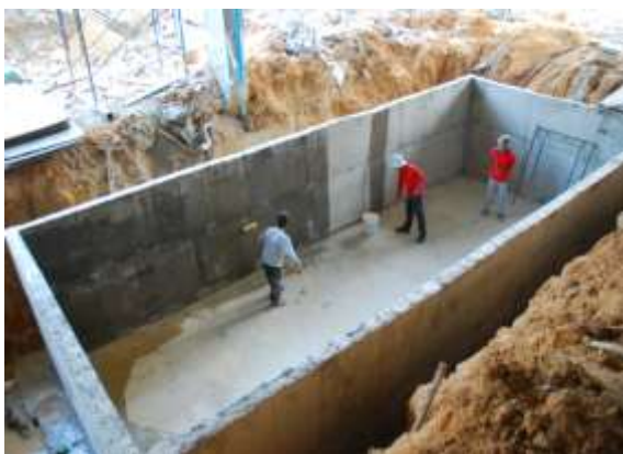
รูปที่ 5.5 ระบบบ่อสำรองน้ำประปา สำหรับใช้ สอยและดับเพลิง ขณะกำลังเคลือบผิวน้ำยากัน ซึม
