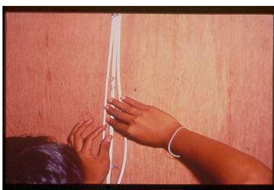
รูปที่ 5.61 การรัดสายไฟฟ้าให้เป็นเส้นตรงก่อนใช้เข็มขัดรัดสายไฟฟ้าให้ติดกับผนัง
