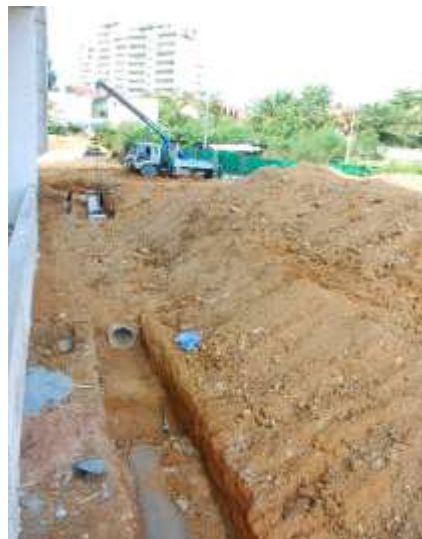
รูปที่ 5.26 การเทคอนกรีตดินให้ได้ระดับเพื่อรองรับท้องท่อและบ่อพัก
