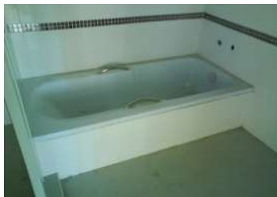
รูปที่ 5.34 การติดตั้งอ่างอาบน้ำ
