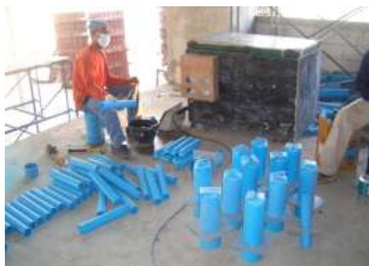
รูปที่ 5.13 การทำหัวอุดท่อเพื่อป้องกันเศษวัสดุและสิ่งสกปรกลงไปในท่อนก่อนการเชื่อมประสาน
