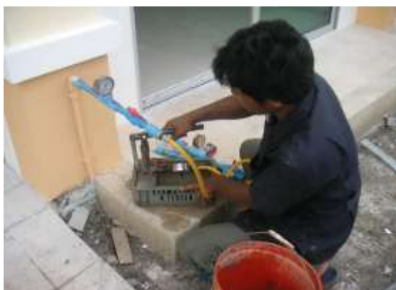
รูปที่ 5.41 ต้องมีการตรวจสอบแรงดันน้ำใน ท่อน้ำดีให้ได้มาตรฐานก่อนติดตั้งสุขภัณฑ์ และอุปกรณ์ประจำสุขภัณฑ์
