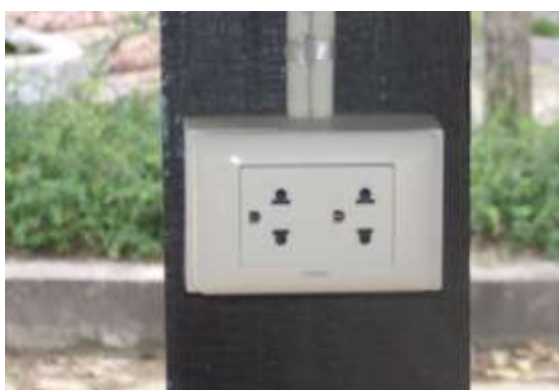
รูปที่ 5.67 การติดตั้งเต้าเสียบต้องเป็นระเบียบเรียบร้อยไม่เอียง
