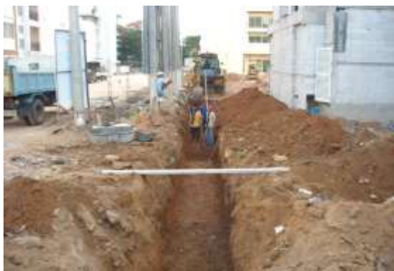
รูปที่ 5.25 การขุดร่องดินในการวางท่อและบ่อพัก
