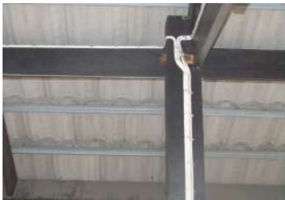
รูปที่ 5.63 การจัดสายเมนหลบหัวน๊อตที่ไม่เป็นระเบียบ
