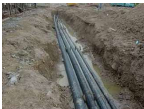
รูปที่ 5.2 เมื่อปิดรอยเชื่อมต่อทั้งหมดแล้วจึงสามารถกลบดินได้
