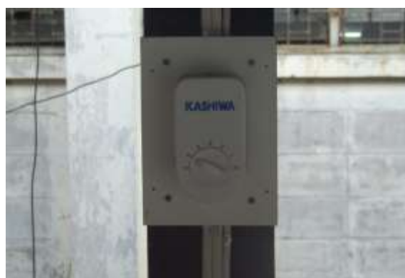
รูปที่ 5.68 การติดตั้งสวิทช์พัดลมต้องเป็นระเบียบเรียบร้อยไม่เอียง
