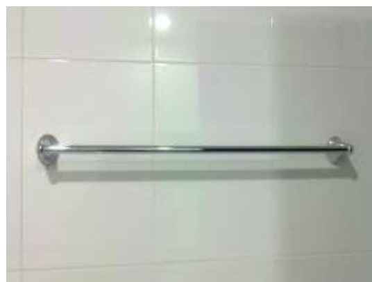
รูปที่ 5.42 การติดตั้งราวตากผ้า
