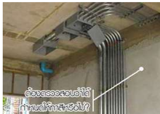
รูปที่ 5.74 การติดตั้งท่อร้อยสายไฟฟ้าแบบเดินลอยเกาะผนัง ผนังมีอุปกรณ์ยึดที่มั่นคง
