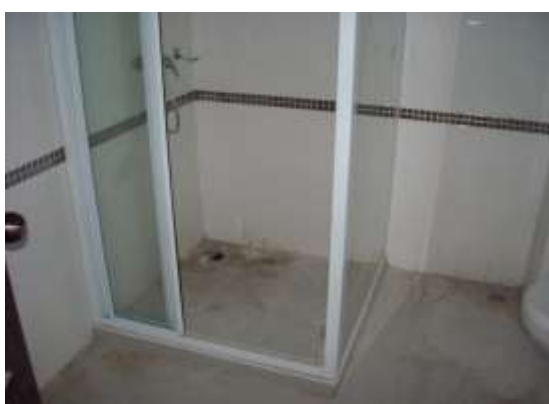
รูปที่ 5.36 การติดตั้งตู้อาบน้ำ
