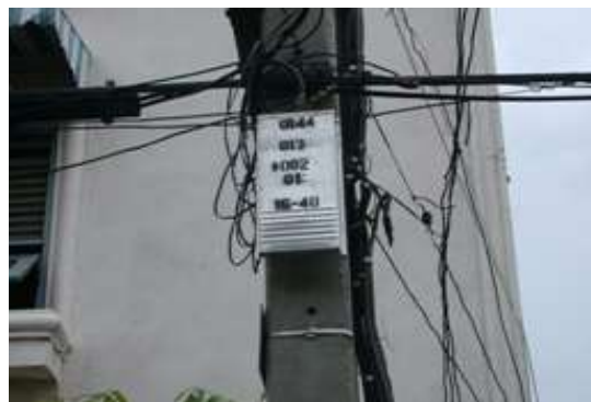
รูปที่ 5.90 การพาดสายและติดตั้งอุปกรณ์โทรศัพท์บนเสาไฟฟ้า
