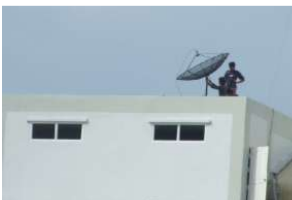
รูปที่ 5.93 การติดตั้งจานดาวเทียม
