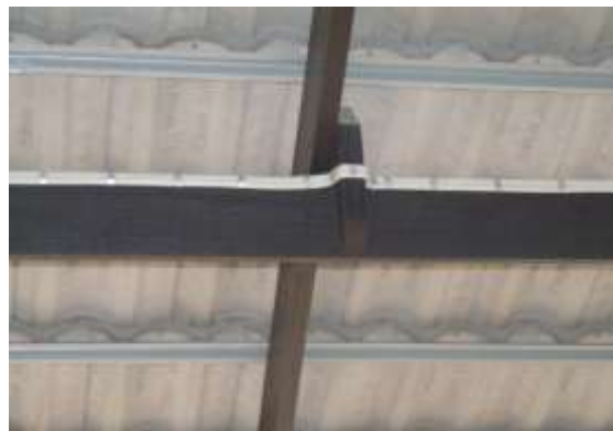
รูปที่ 5.64 สายไฟฟ้าบริเวณที่มีผิวไม้เรียบต้องเดินสายไฟให้เป็นระเบียบเรียบร้อย
