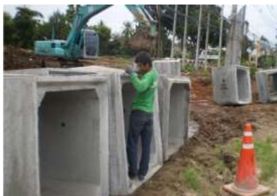
รูปที่ 5.29 การจัดเรียงท่อน้ำประเภทท่อกี่เหลี่ยม (Block Convert) ก่อนทำการติดตั้งเพื่อสะดวกในการทำงาน
